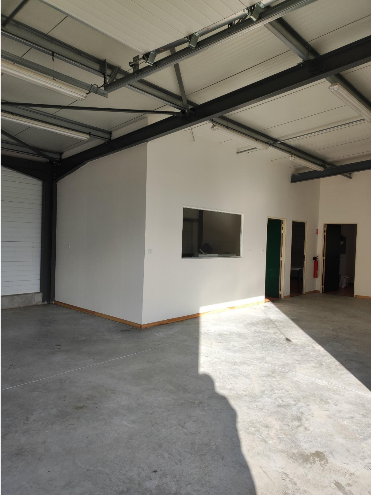
ENTREPÔT et accès aux trois ateliers
