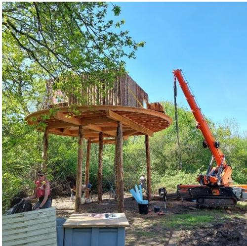
Emprise chantier autour d'une cabane réduite grâce aux engins de levage utilisés
