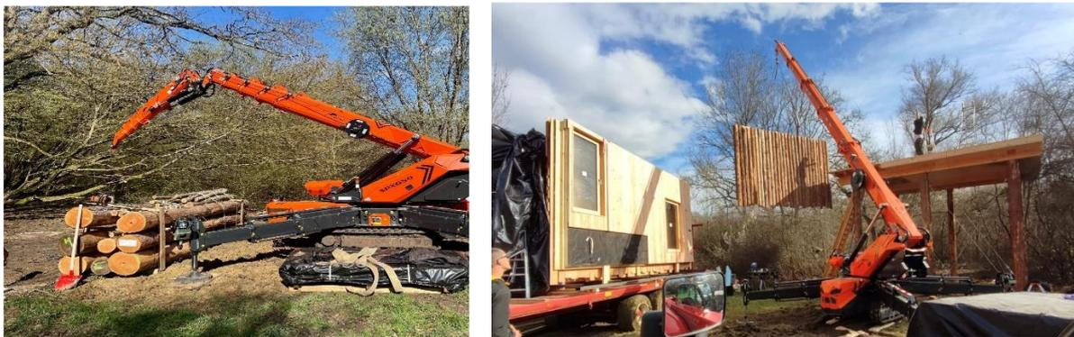
Photo 2 : Photographies de principe du montage des cabanes (COUCOO, 2023)
