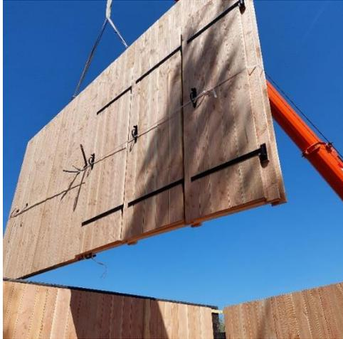
*Levage lors de la pose d'un panneau 2D fabriqué en atelier*
