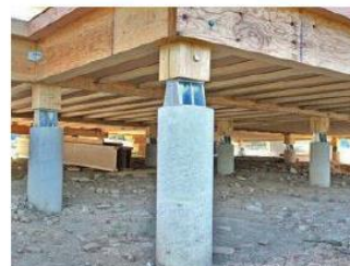
OPTION D'INSTALLATION: PLATEFORME MONTÉE SUR PILOTIS MASSIF EN BÉTON
