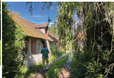
UN ENSEMBLE BÂTI EXISTANT, À L'ABANDON, EN FORME DE CLOS. ENSEMBLE HÉTÉROCLITE: PANS DE BOIS (XVIIIÈME SIÈCLE), BRIQUE ET MAÇONNERIE ENDUITE (RÉCENT).
