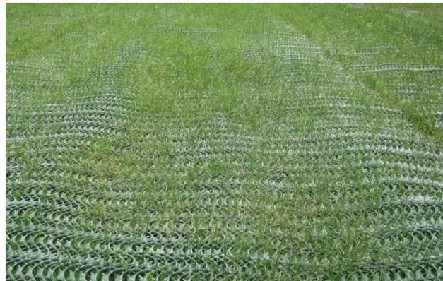
Photo 73 : Dispositif alvéolé Grass Protecta (Source [kabelis.fr](http://kabelis.fr))
