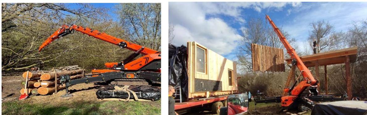
Photo 75 : Photographies de principe du montage des cabanes (COUCOO, 2023)
